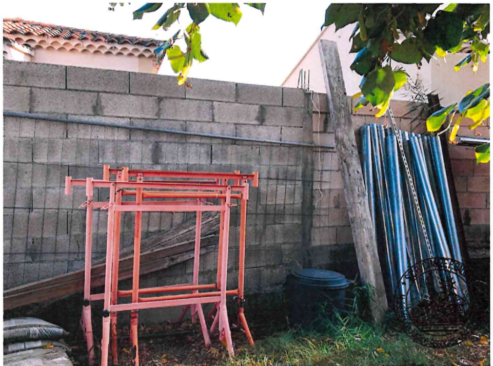
6 Mur de clôture Sud
