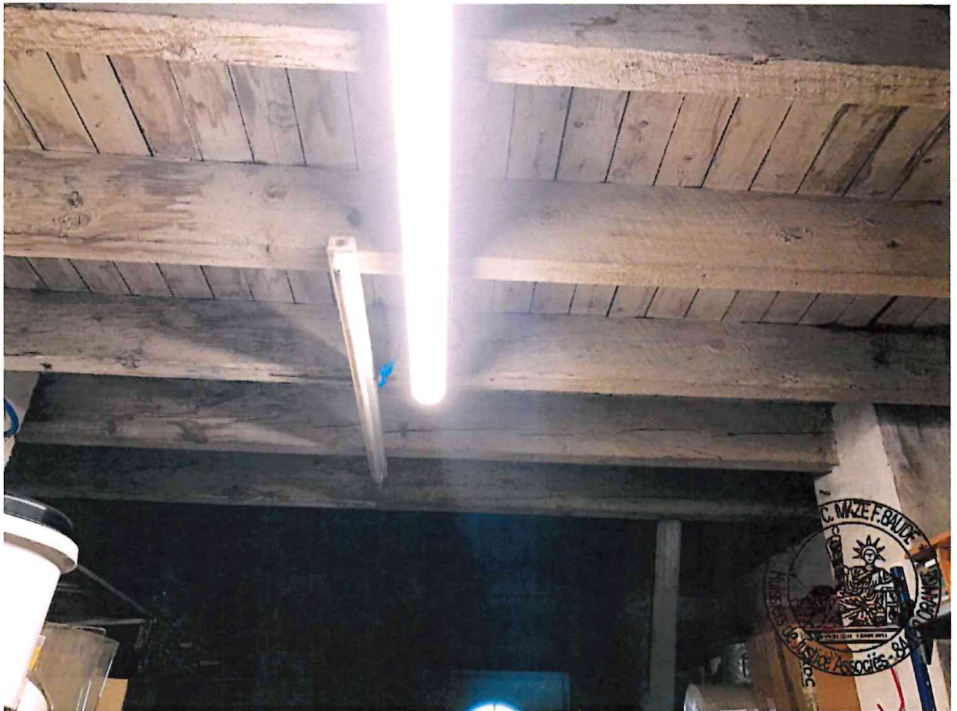
6. Plafond en bois et poutre
