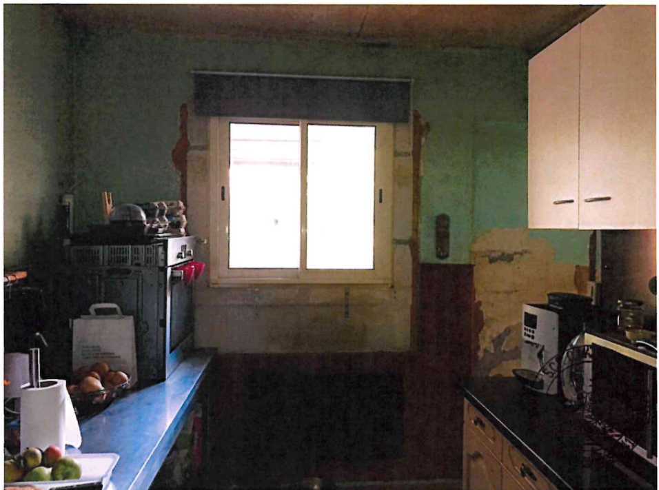
5. Fenêtre Côté Sud
