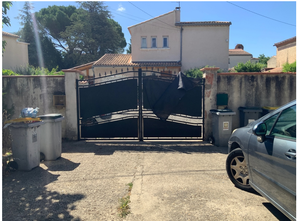
2. Portail s'ouvrant sur la rue du Temple.
